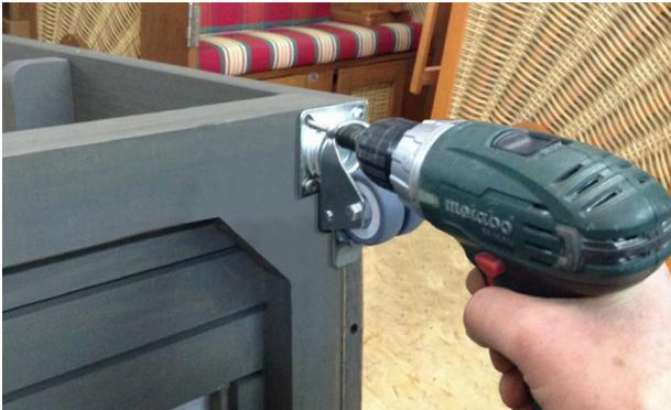
**! Achtung: Löcher mit einem 3mm Bohrer vorbohren !**
